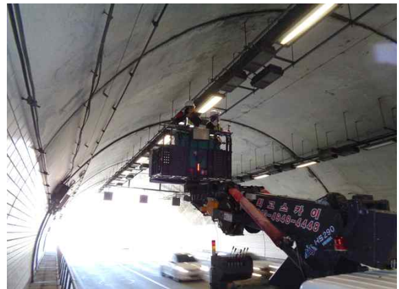
고소작업차를 이용한 외관조사 현황②
