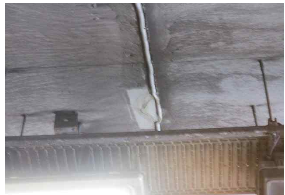
라이닝 SPAN.2 조인트부 박리 보수
