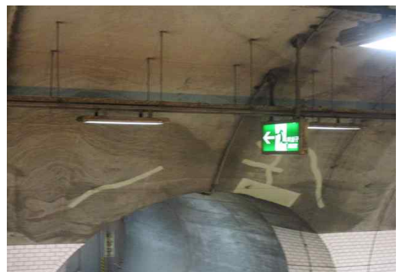
라이닝 SPAN.72 재료분리 보수
