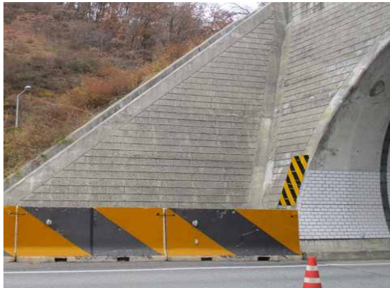
시점부 옹벽 전경
