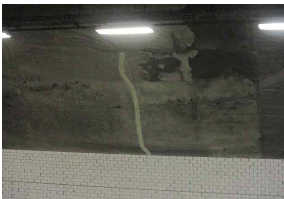
라이닝 SPAN.17 균열 보수
