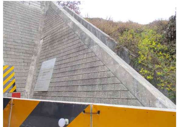
시점부 옹벽 전경
