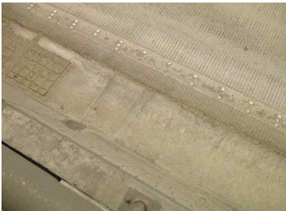
포장부 SPAN.123 포장 균열(0.3mm 이상)
