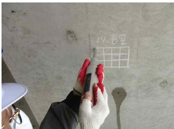
반발경도 측정 현황(측벽부)①
