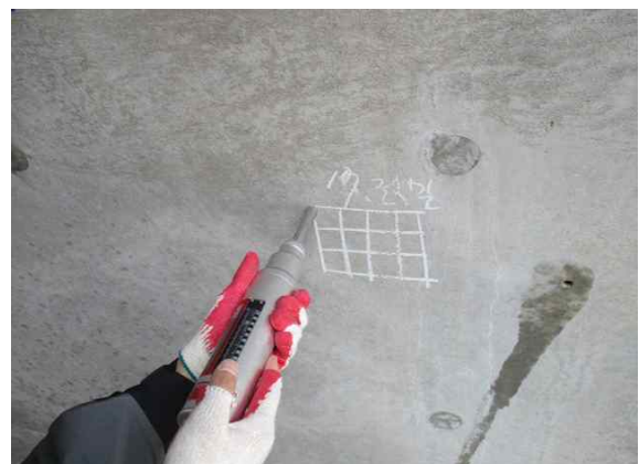
반발경도 측정 현황(측벽부)②
