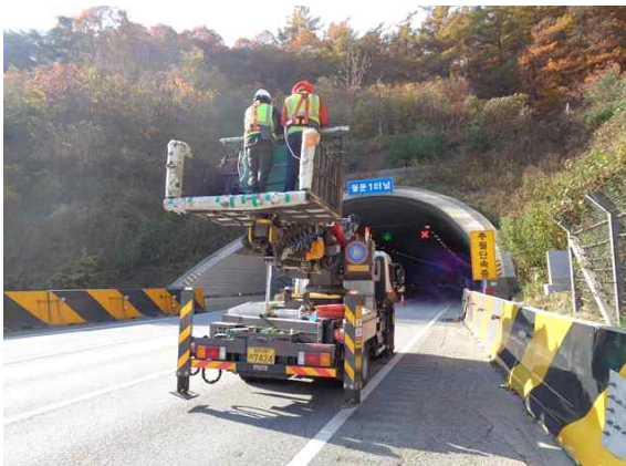
고소작업차를 이용한 외관조사 현황①
